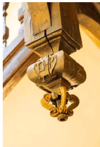
Le Palais Canilhac Villeneuve Les Avignon Monument Historique 67 appartements
