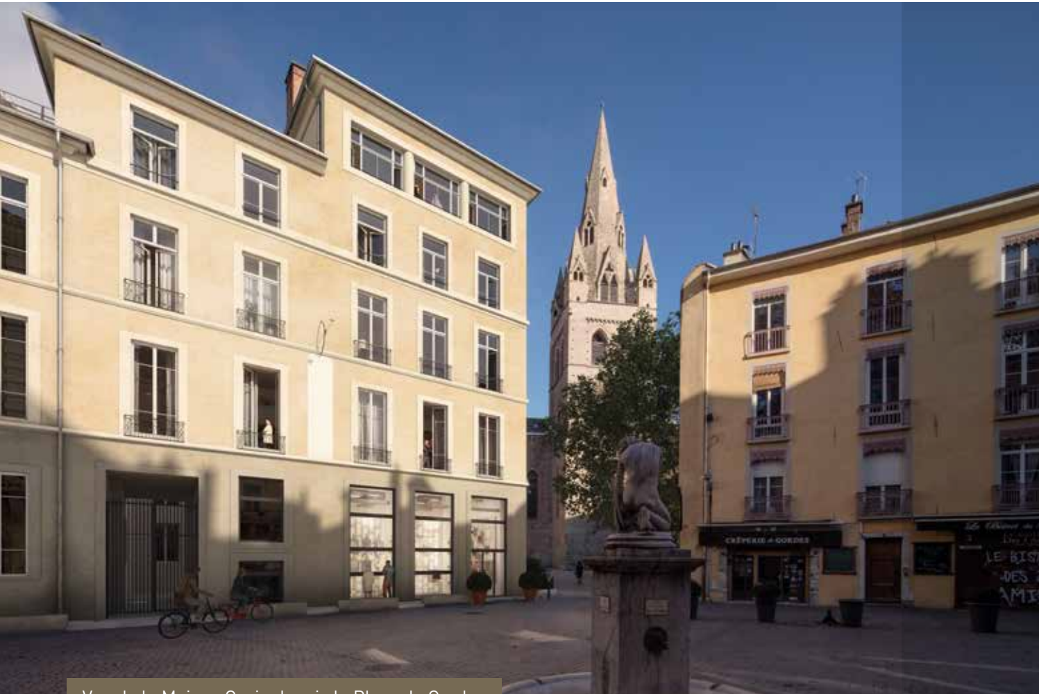
Vue de la Maison Gavin depuis la Place de Gordes
